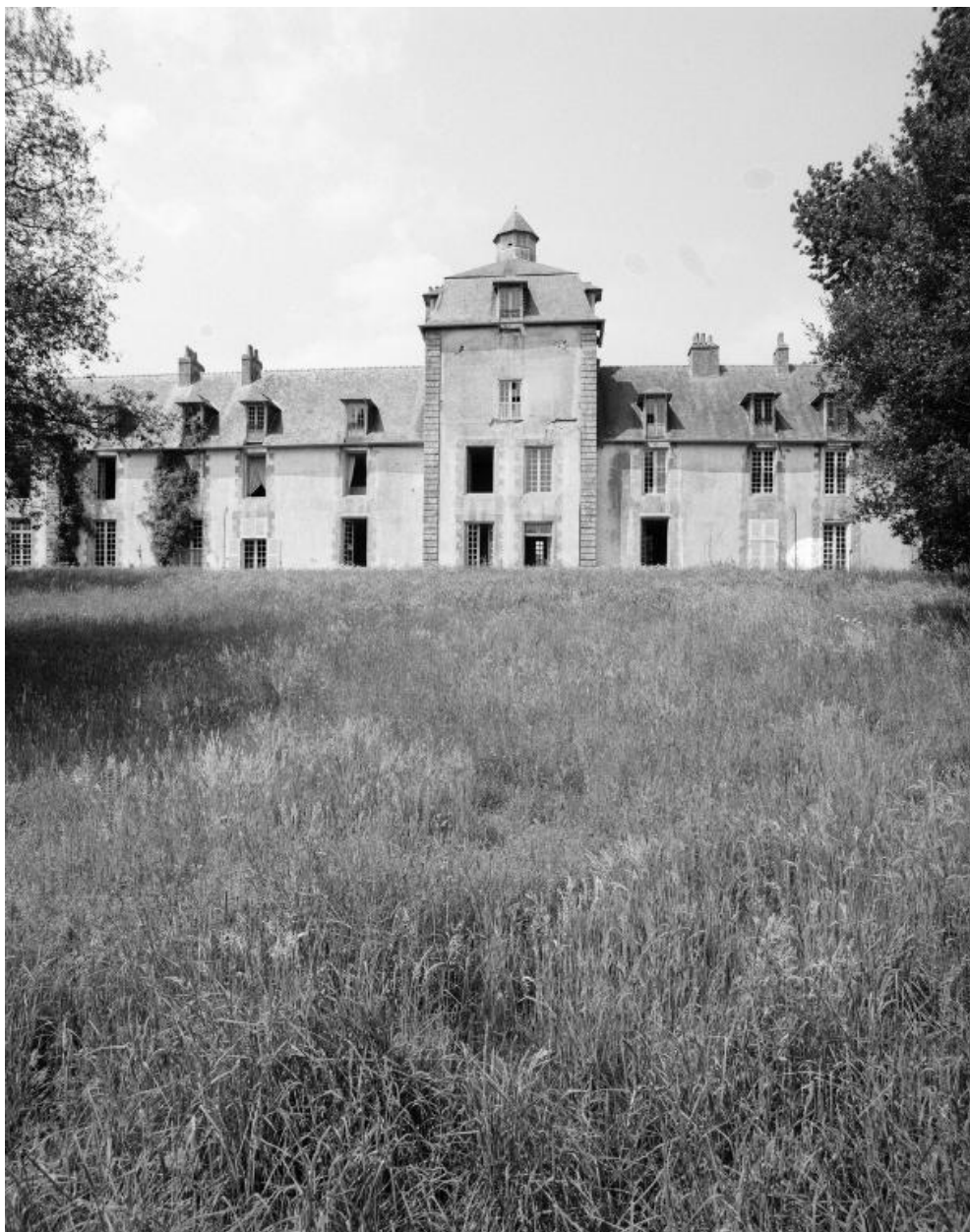
Elévation sud, partie centrale.
