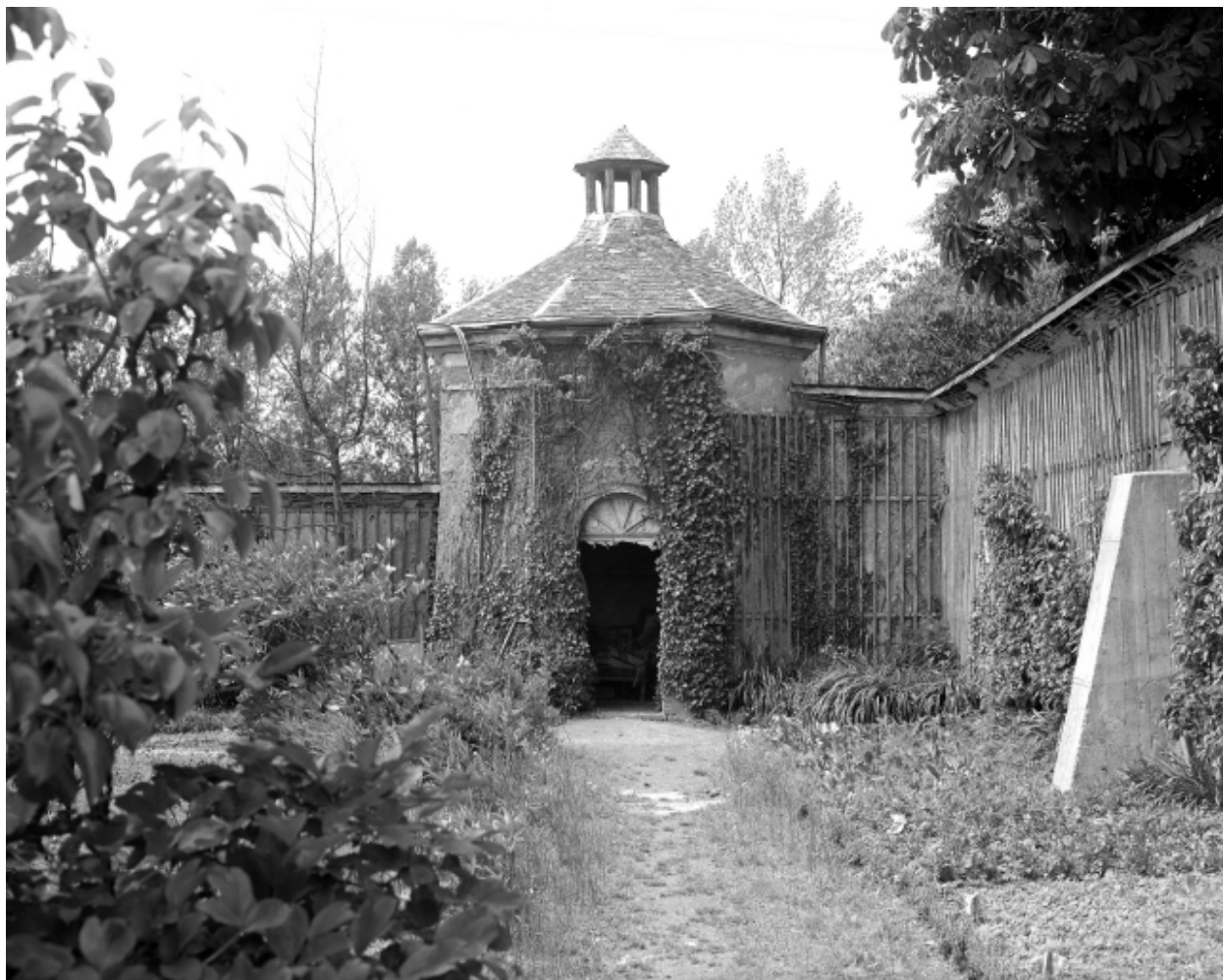
Colombier et murs en terre du jardin
