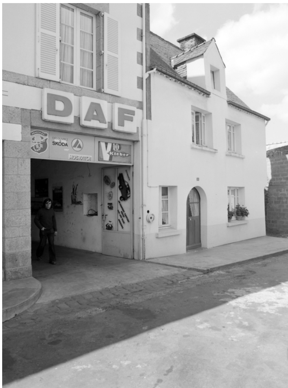
10 place Bisson, vue générale façade nord.
