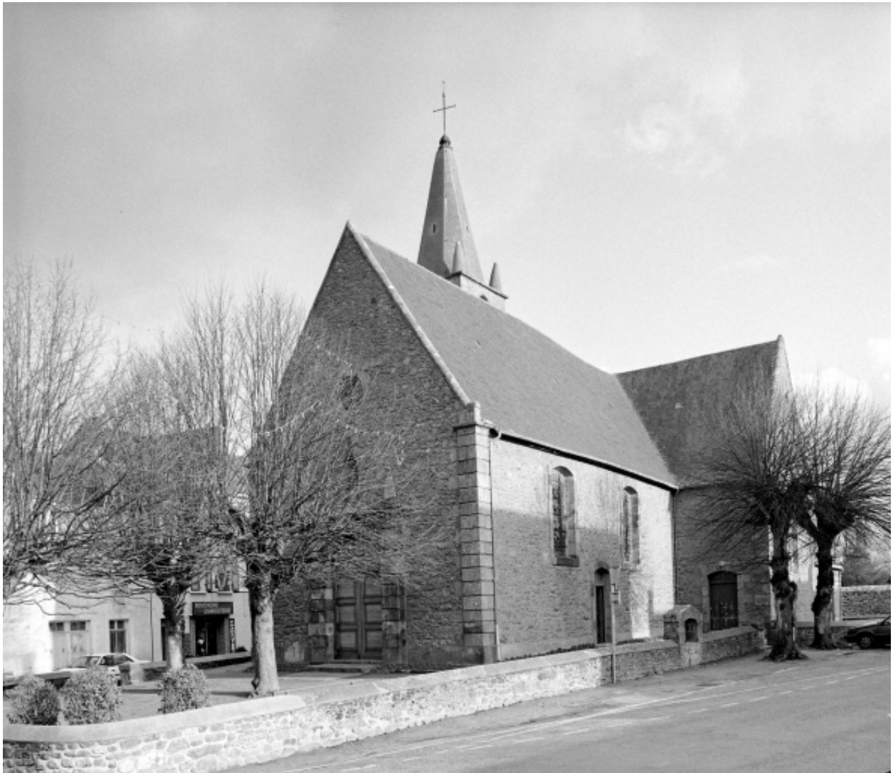
Elévation Sud-Ouest : vue générale
