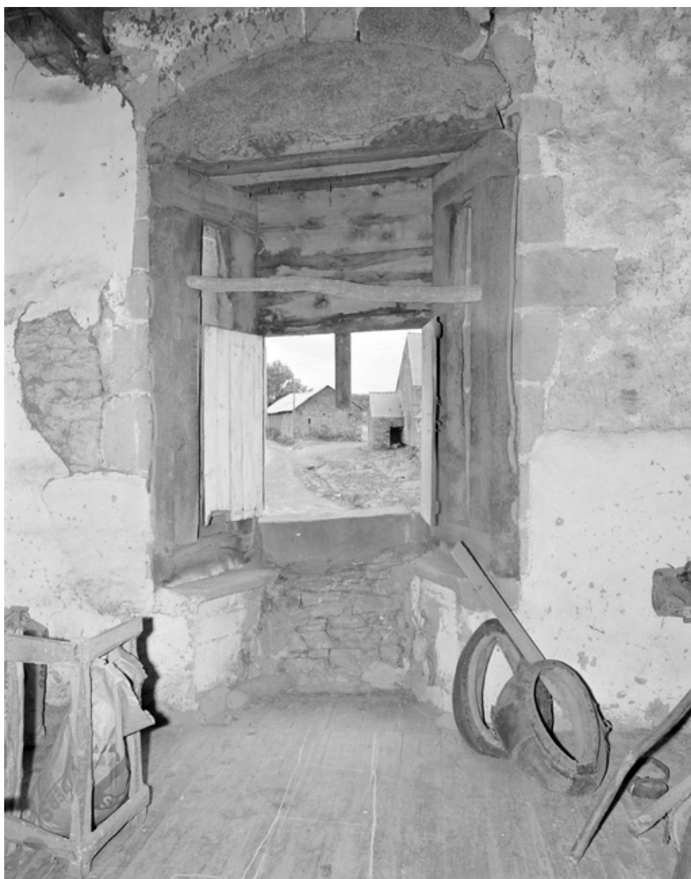
Etage du logis, mur sud de la pièce ouest, fenêtre à coussièges. Etat en 1977.
