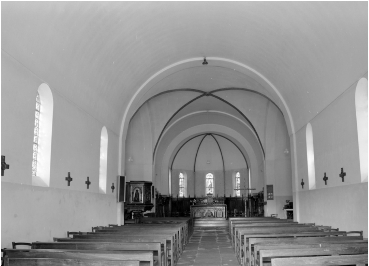
Église : vue générale vers le chœur (état en 1984)
