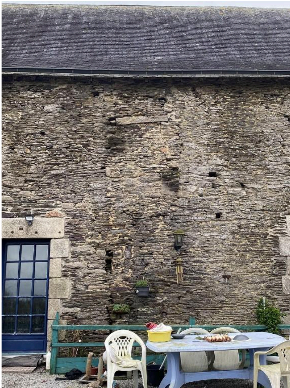
Aile nord, élévation nord, détail
