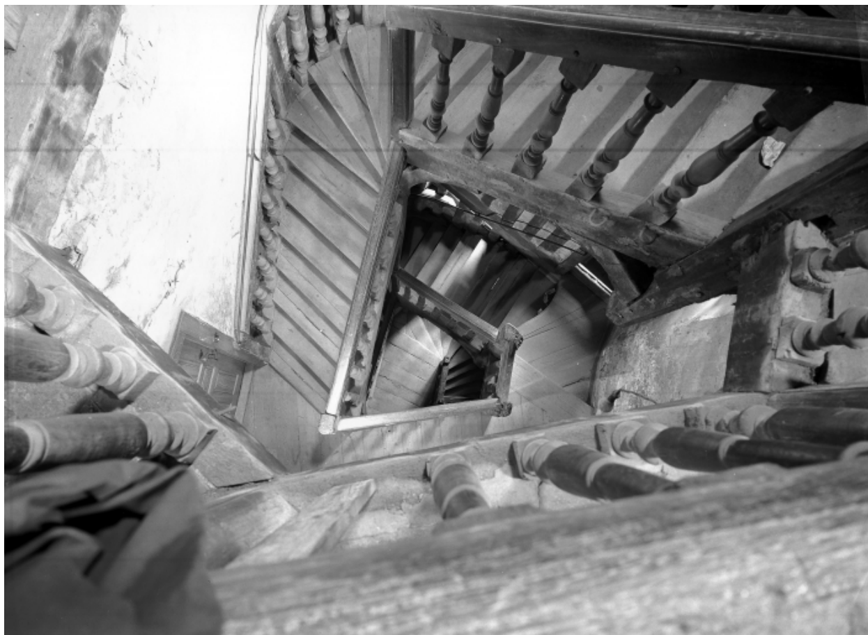
Escalier : vue générale
