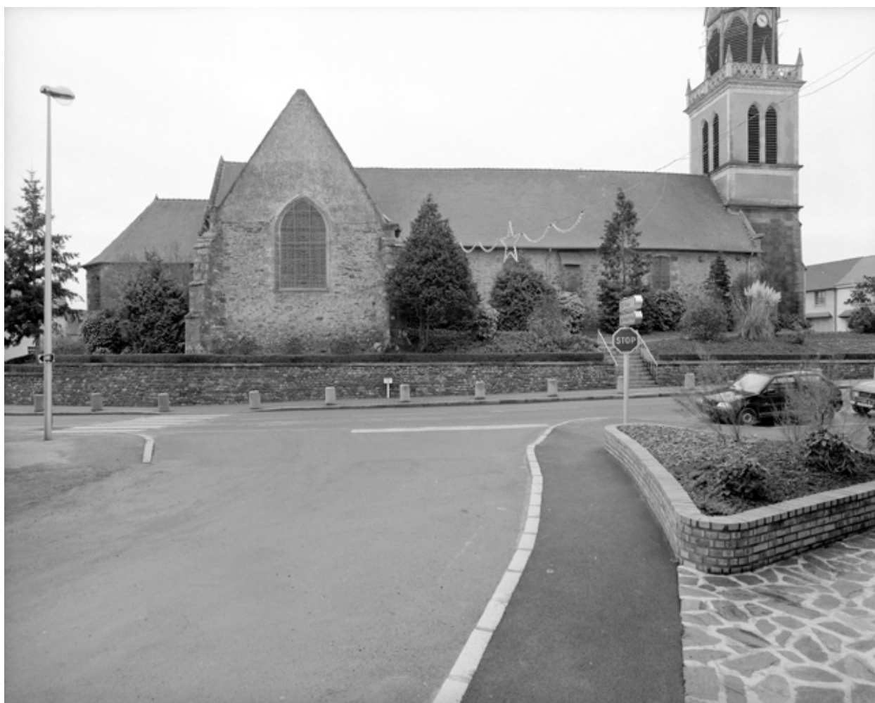
Vue générale nord
