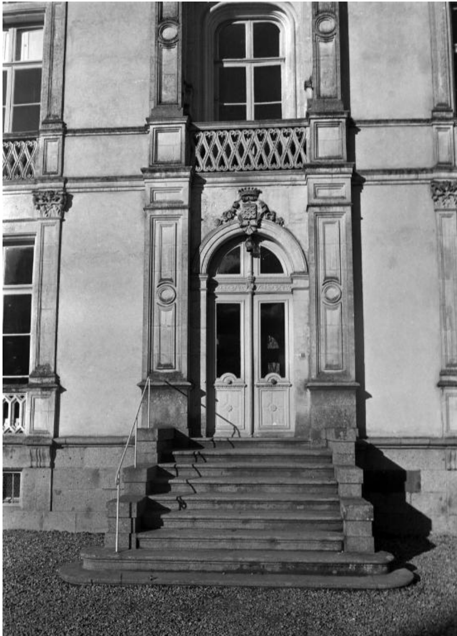
Porte d'entrée façade sud (état en 1973)
