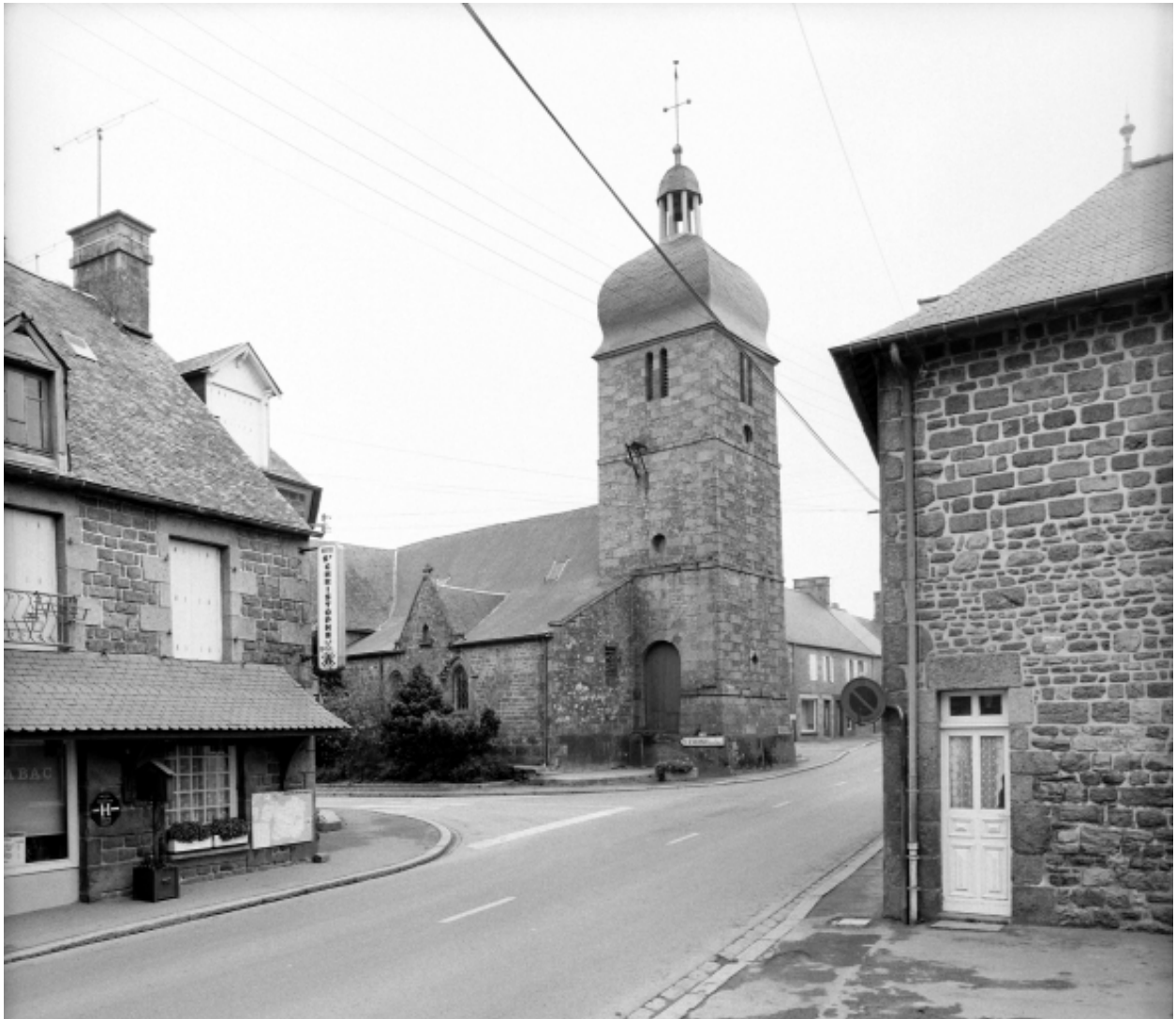
Elévation Nord-Ouest : vue générale
