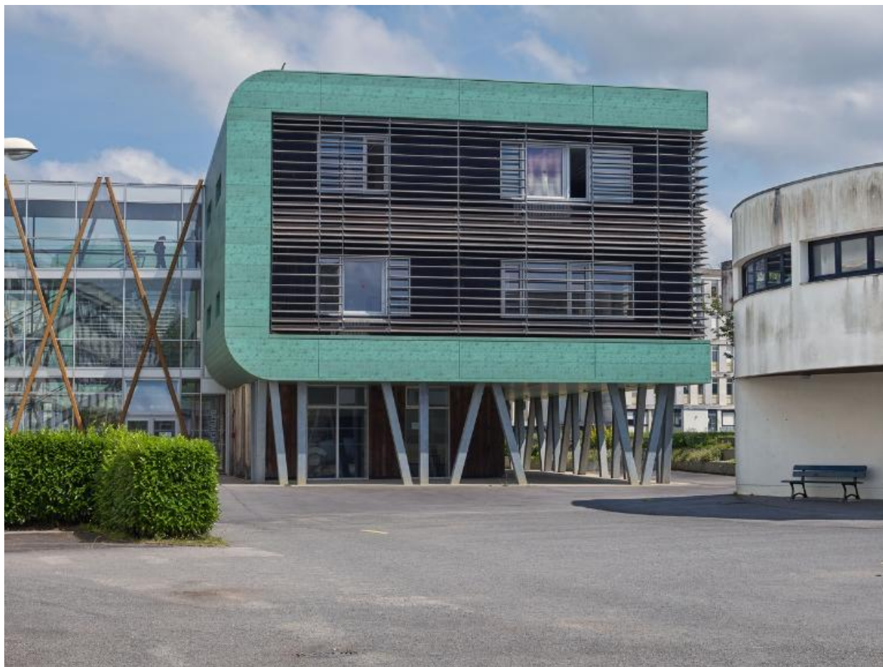
Vue partielle de la façade ouest de l'espace sciences (bâtiments B2 et B3). Thierry Soquet, architecte, 2015.
