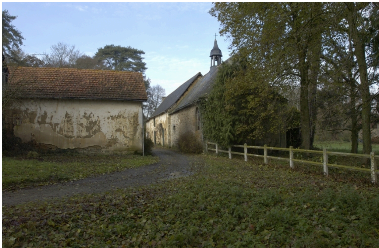
Chapelle et dépendances : vue générale sud-ouest
