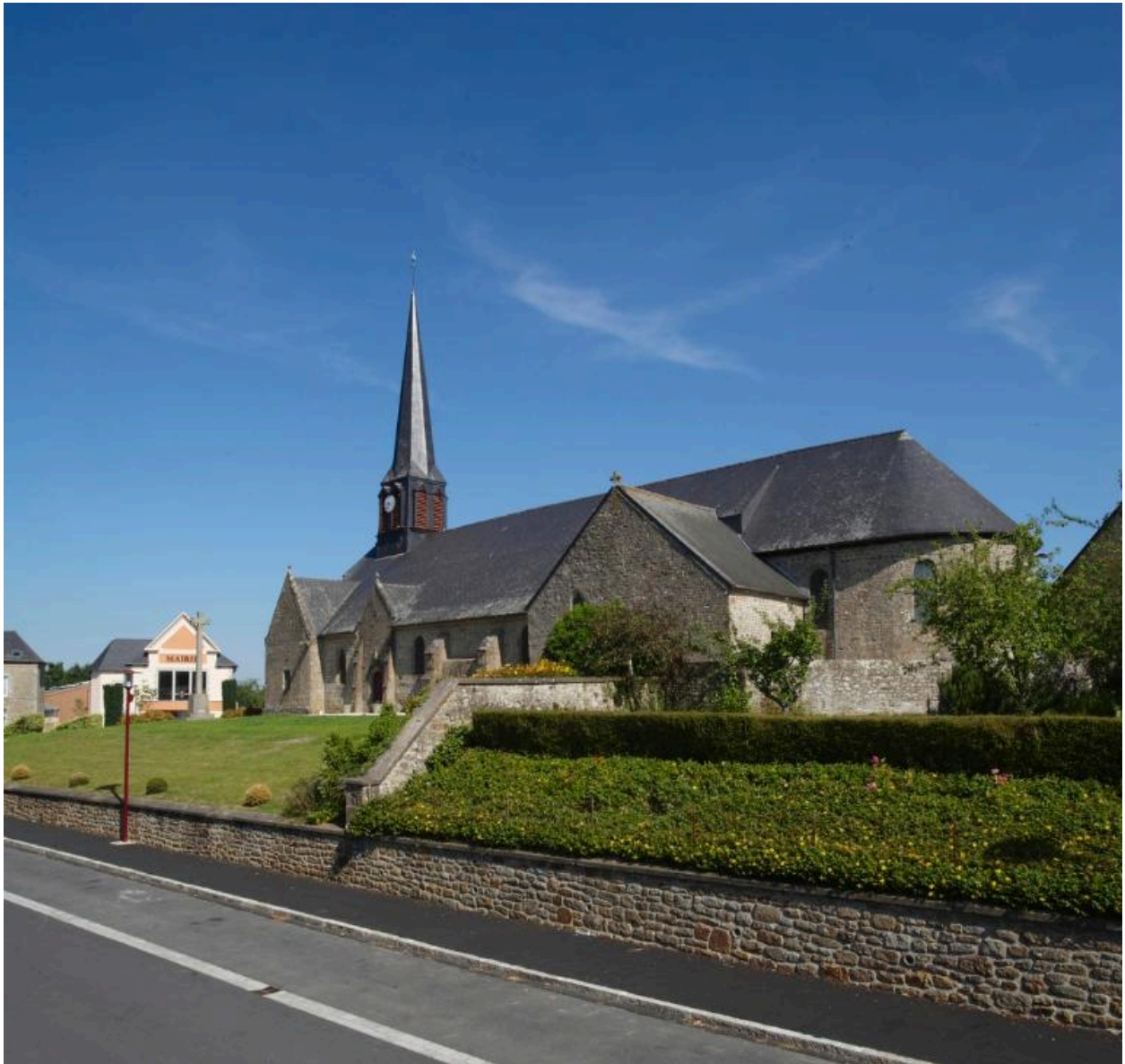
Elévation Sud : vue du sud-est
