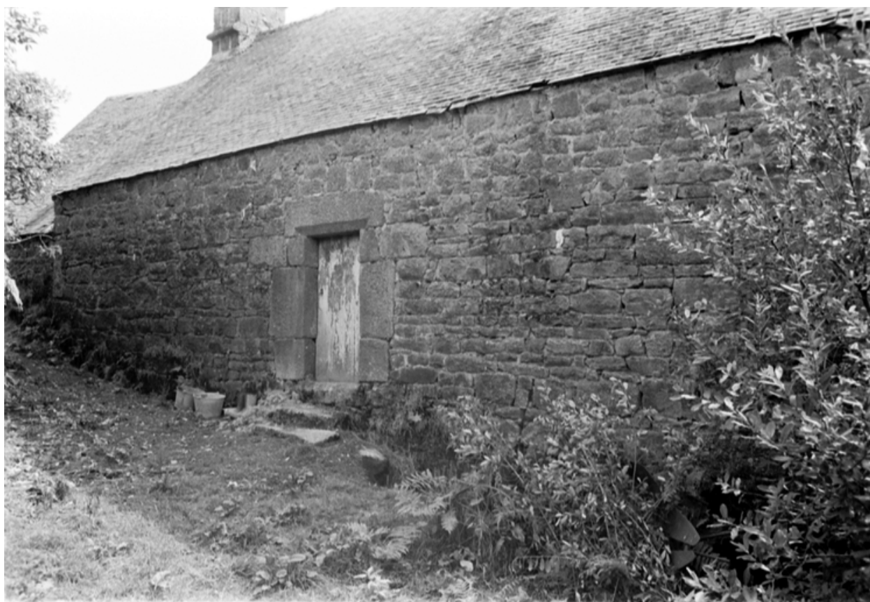
Face nord : vue générale
