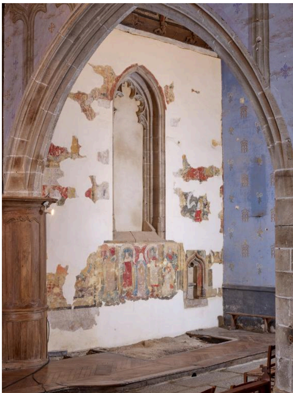
Vue du mur est du transept sud
