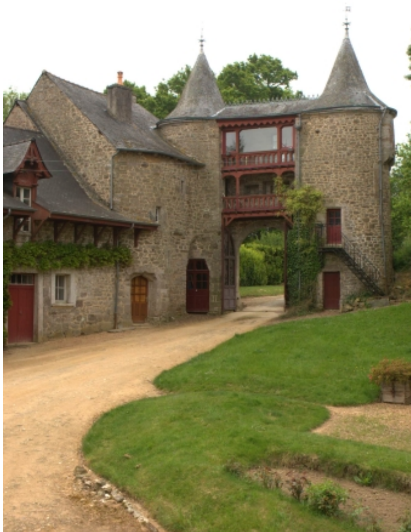
Châtelet d'entrée, vue arrière
