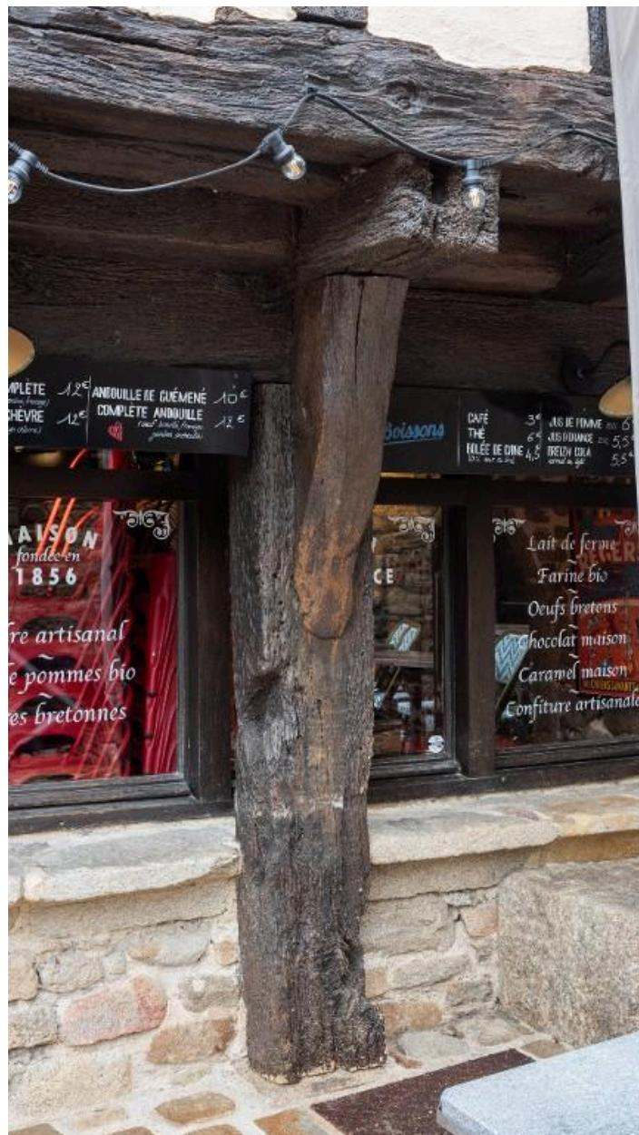
Un pigeâtre renforce l'assemblage entre le poteau et la solive, dans cet encorbellement prononcé.
