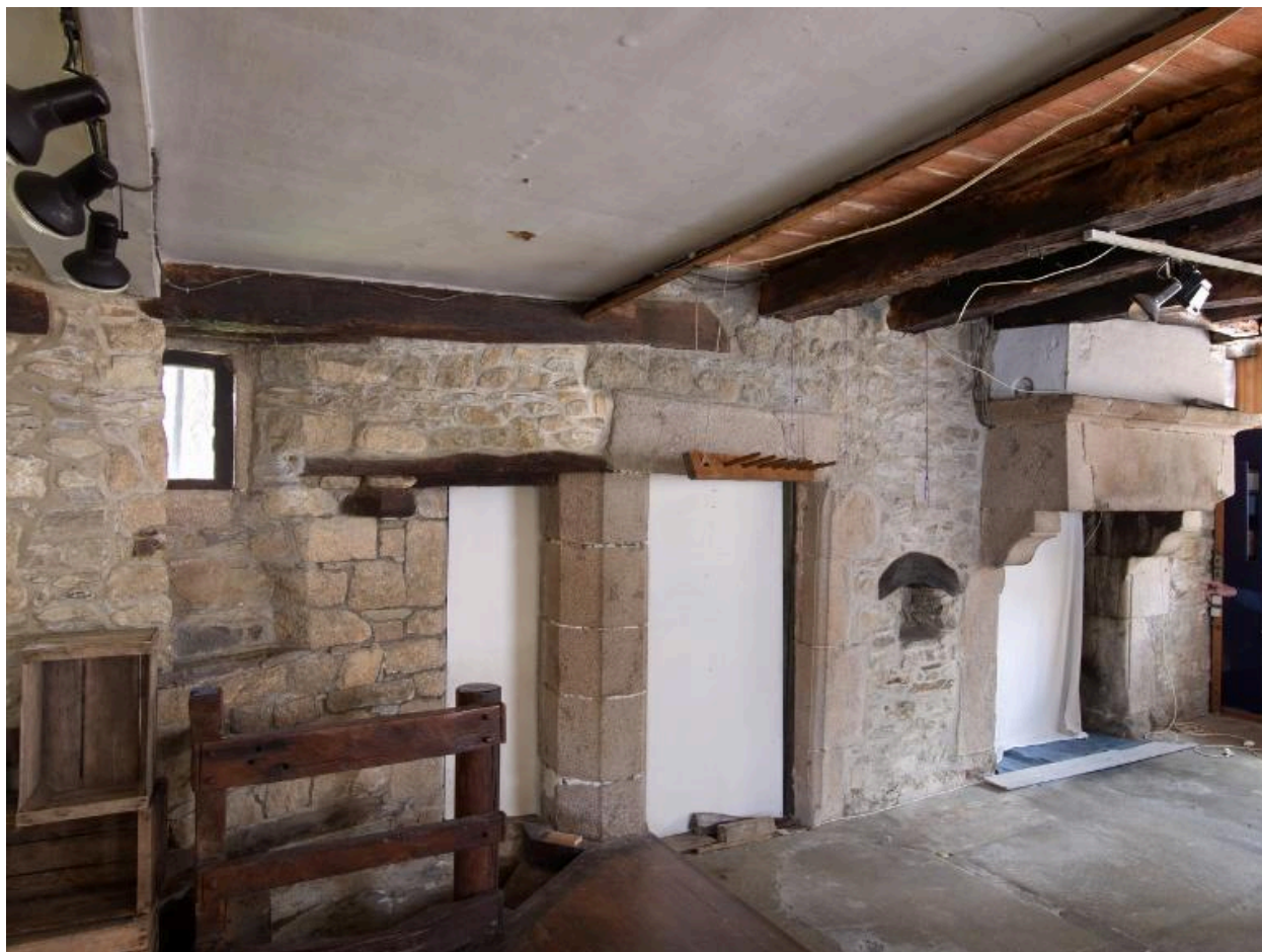
Rez-de-chaussée. Mur gouttereau sud. Portes jumelées ouvrant sur la tour d'escalier et cheminée de la pièce avant
