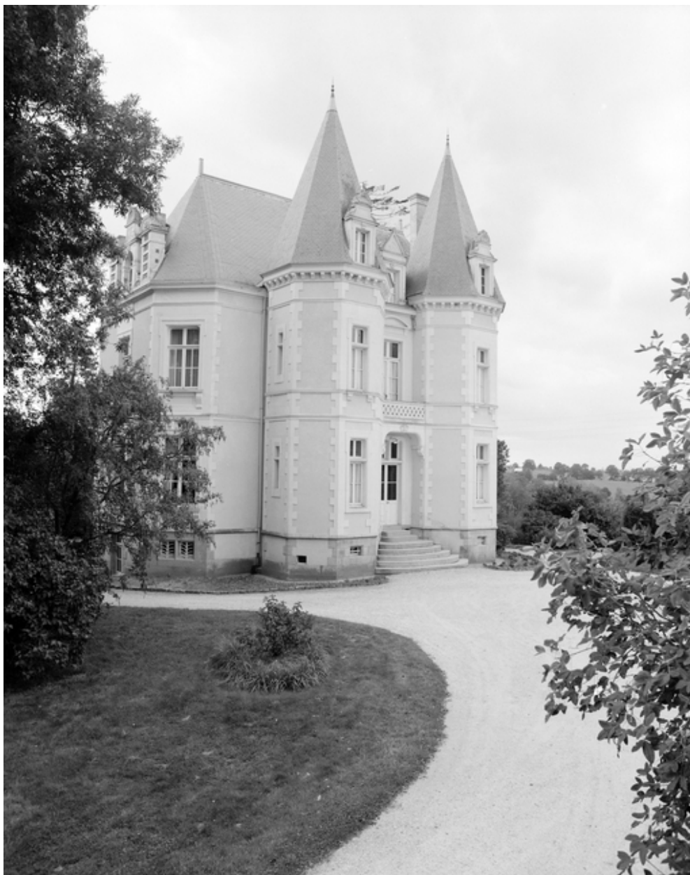
Vue générale nord.
