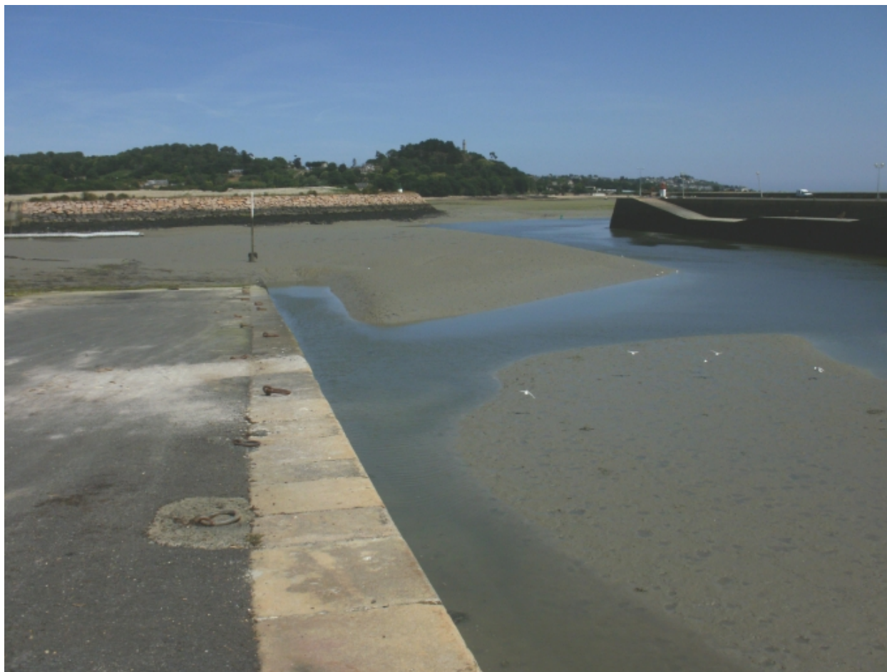
Vue de la bordure de quai en pierre de taille
