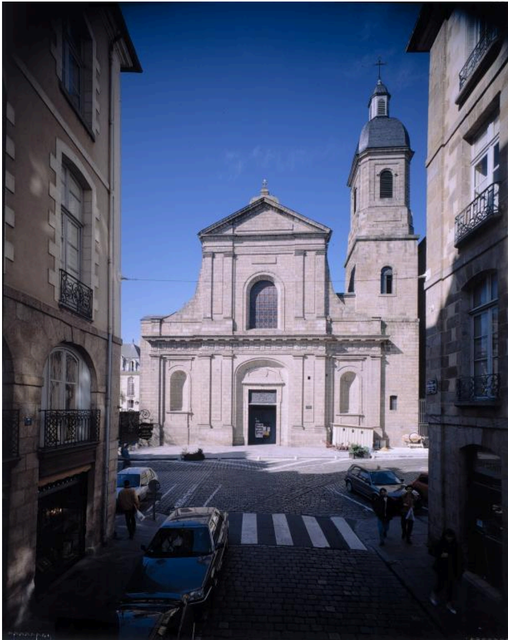
Elévation Ouest : vue générale.
