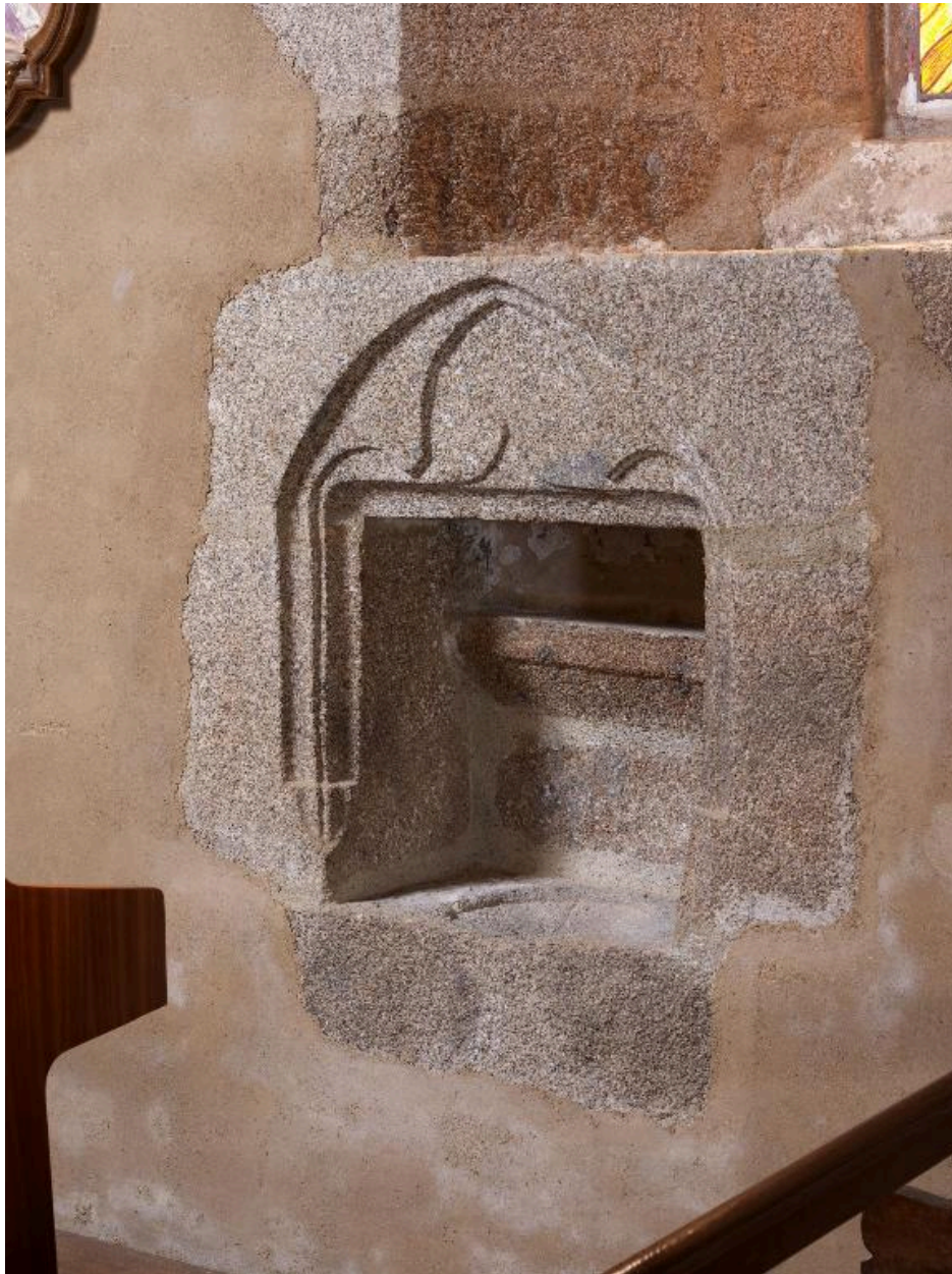
Niche trilobée du pignon sud-ouest
