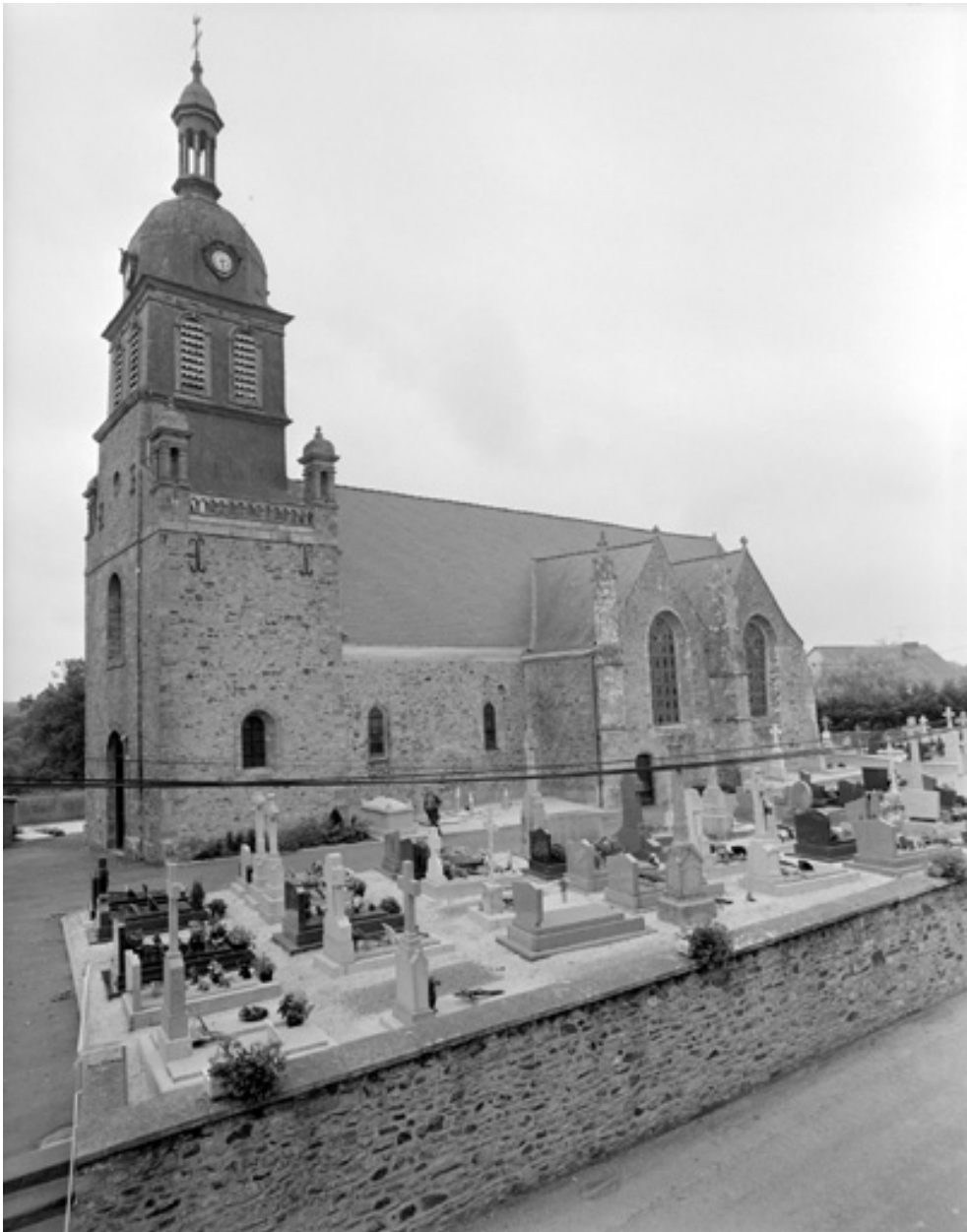
Vue générale : élévation sud-ouest
