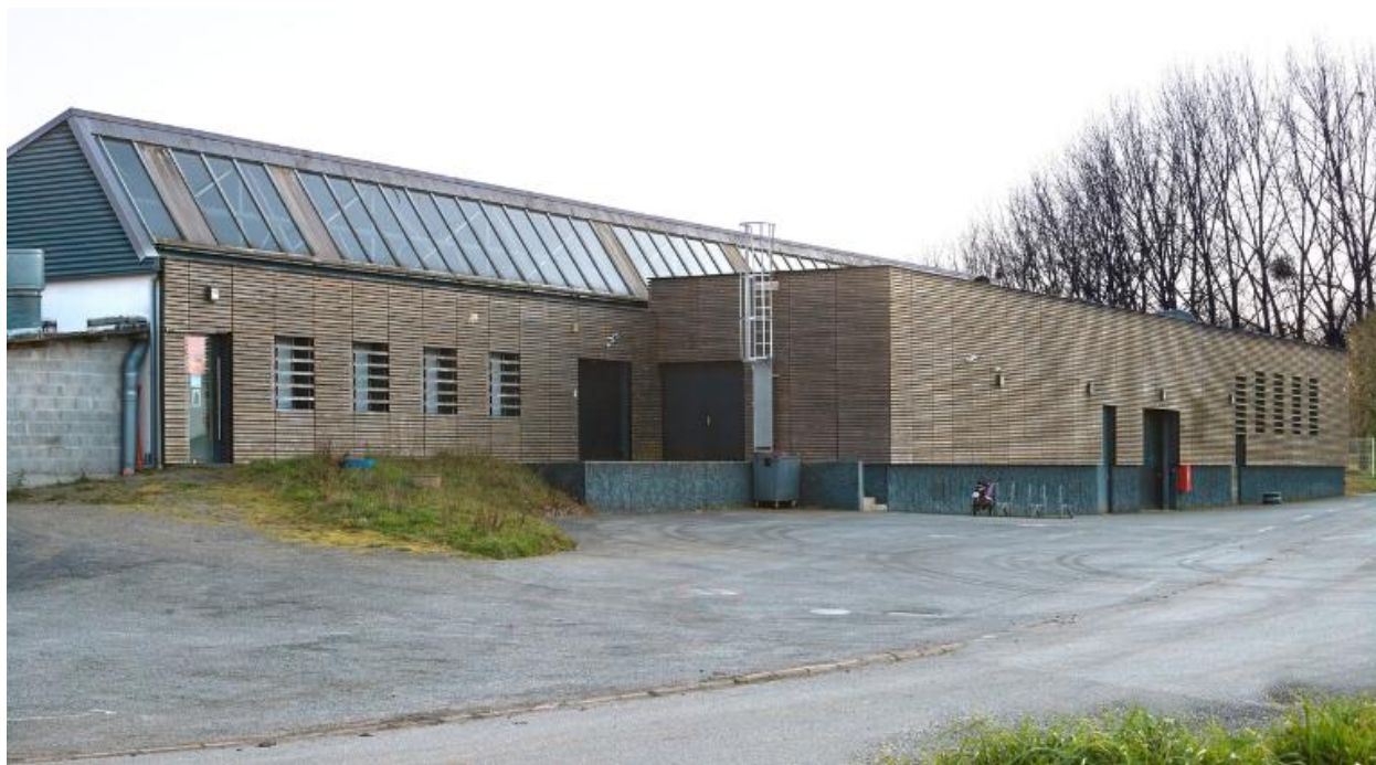
Façade nord des ateliers sous sheds restructurés, étendus et rénovés (Lionel Dunet architecte, 2008-2012).
