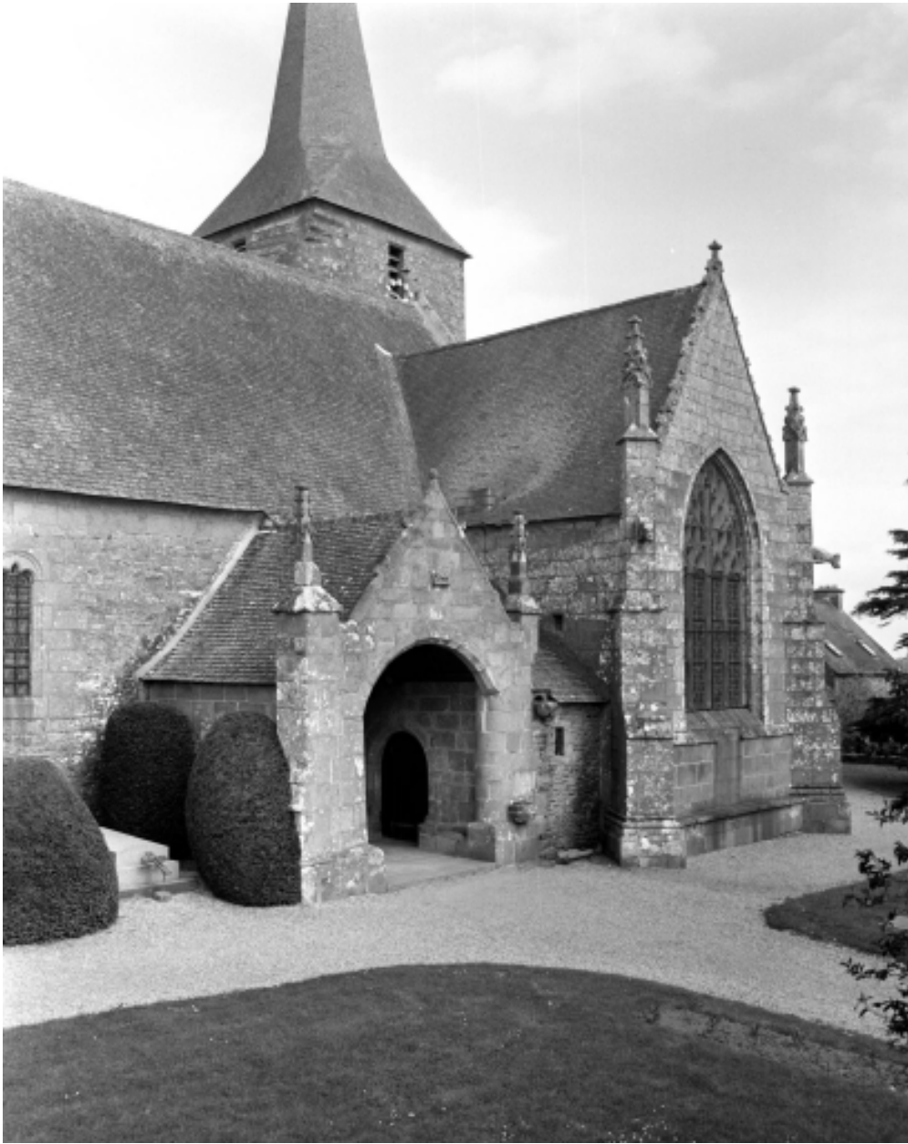
Vue partielle nord ouest
