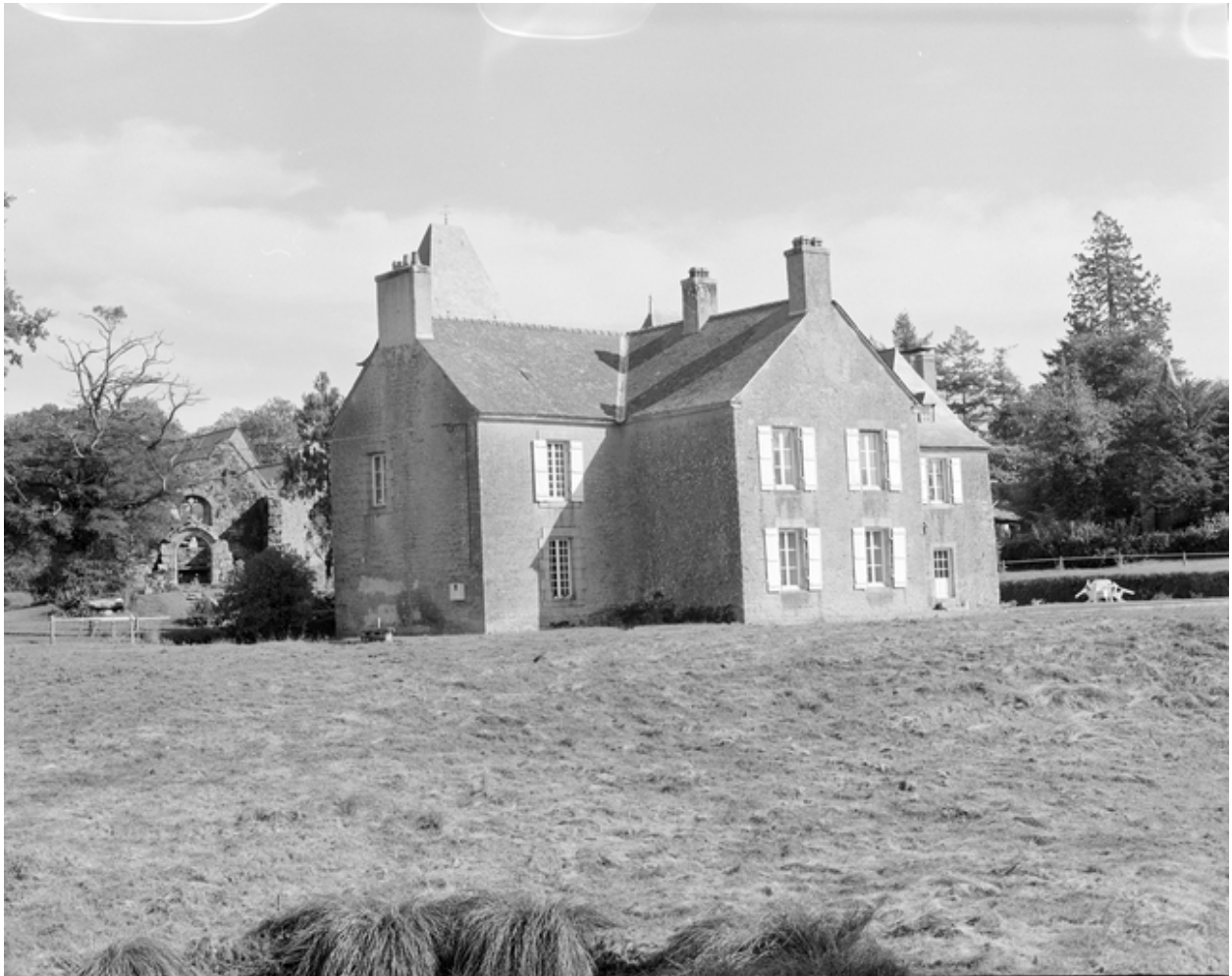
Château, vue générale ouest.
