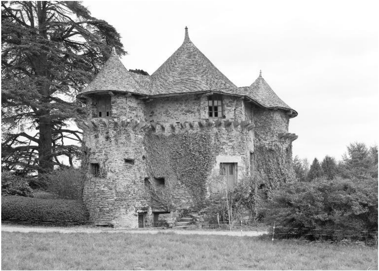
Château, tour nord-est, vue générale.
