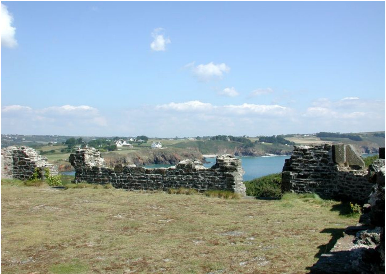
Vue du réduit de batterie de côte de l'île de l'Aber : terrasse, parapet percé d'embrasures et de créneaux de fusillade
