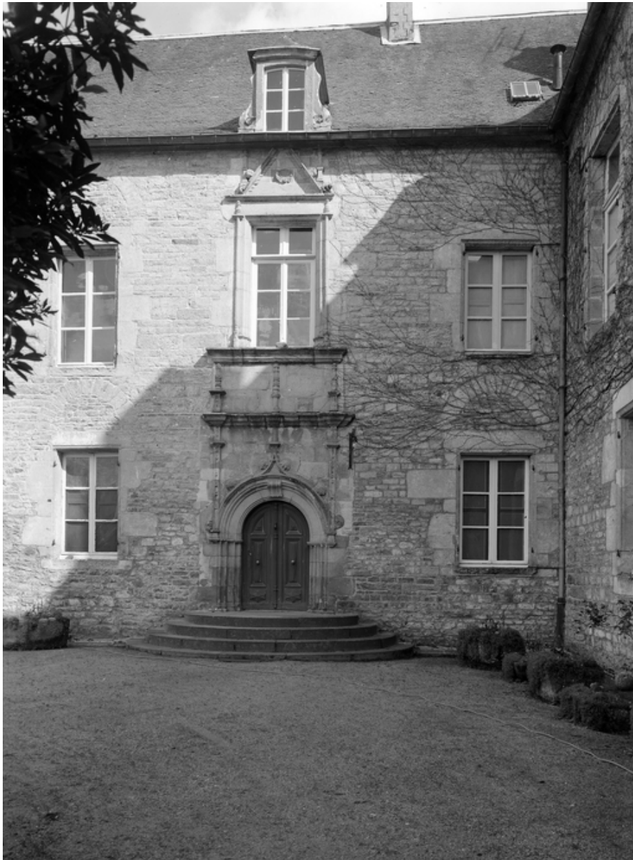
Détail de la travée de la porte d'entrée
