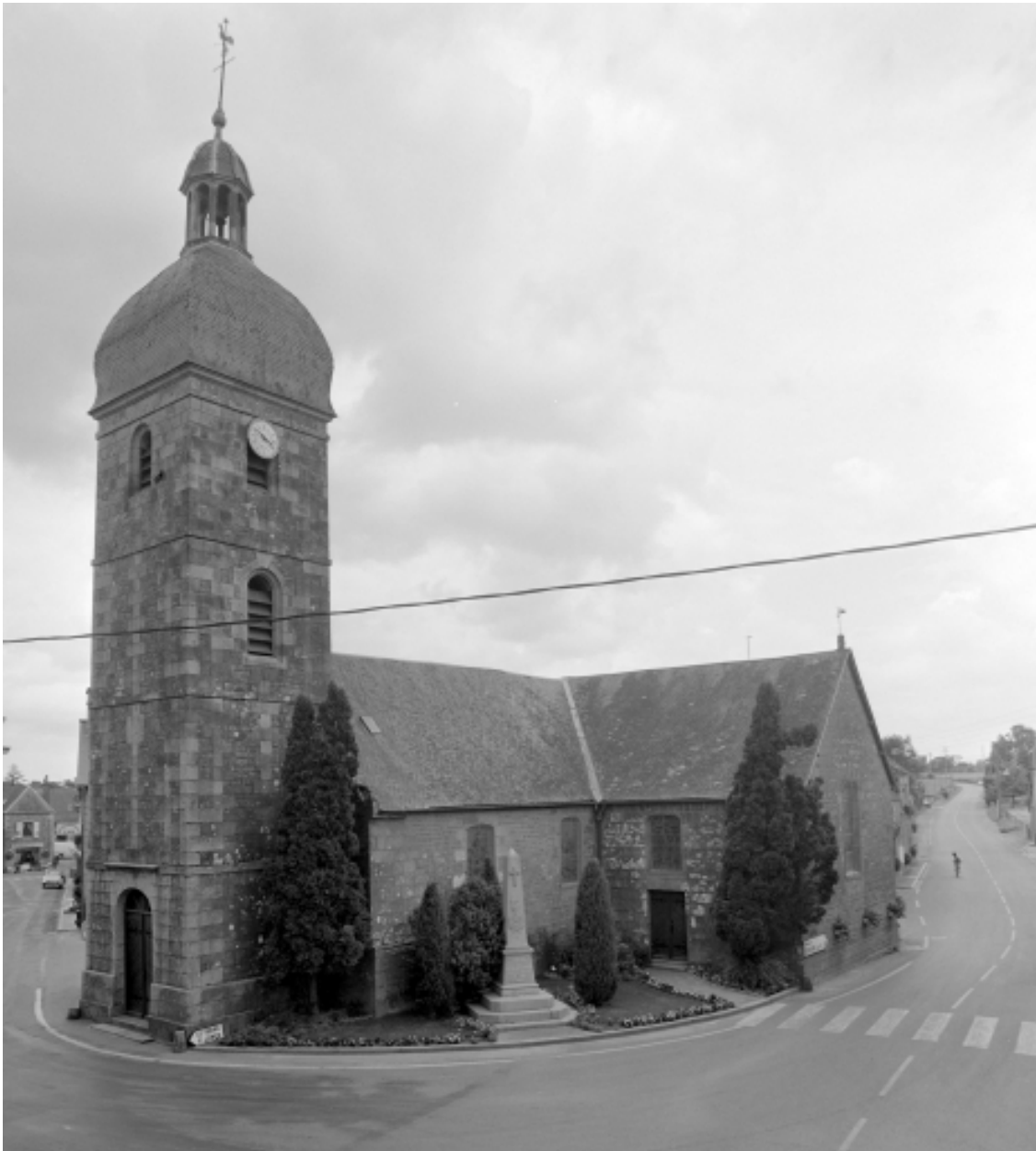
Elévation Sud-Ouest : vue générale
