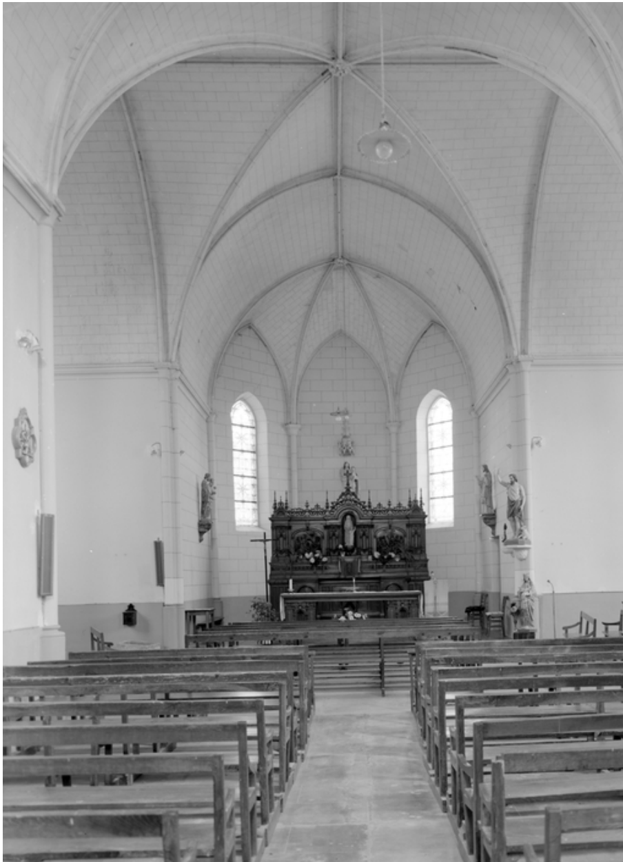
Chapelle : vue générale de la nef (état en 1984)
