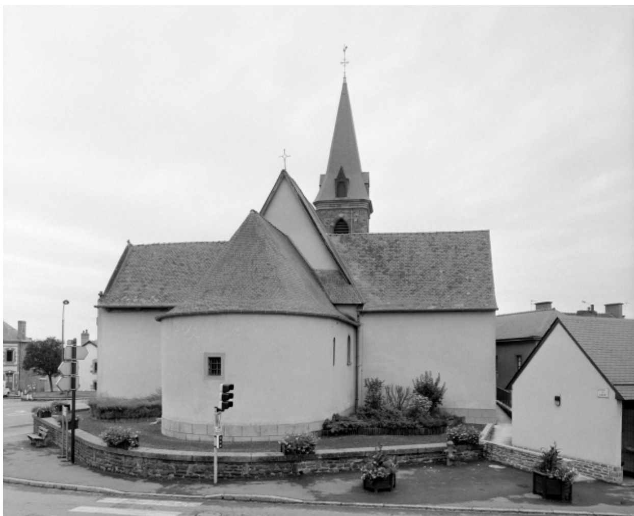
Elévation Est : vue générale
