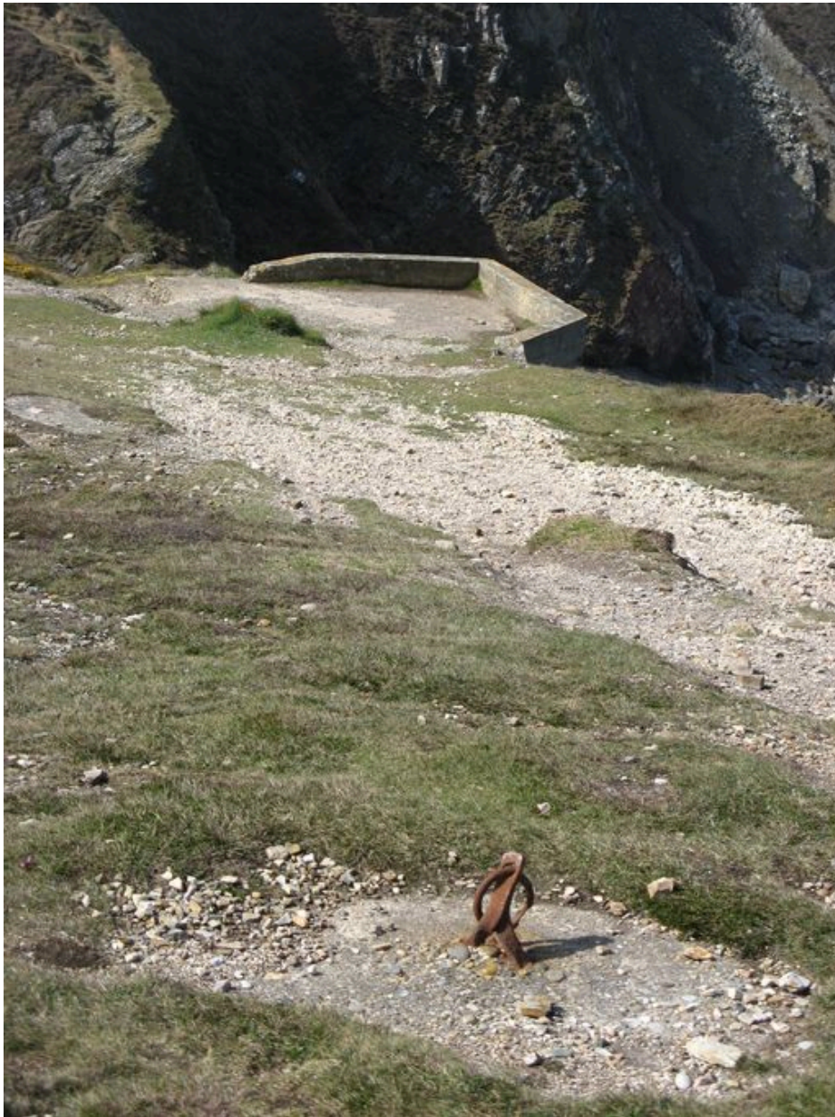
Vue générale du poste de chargement de galets
