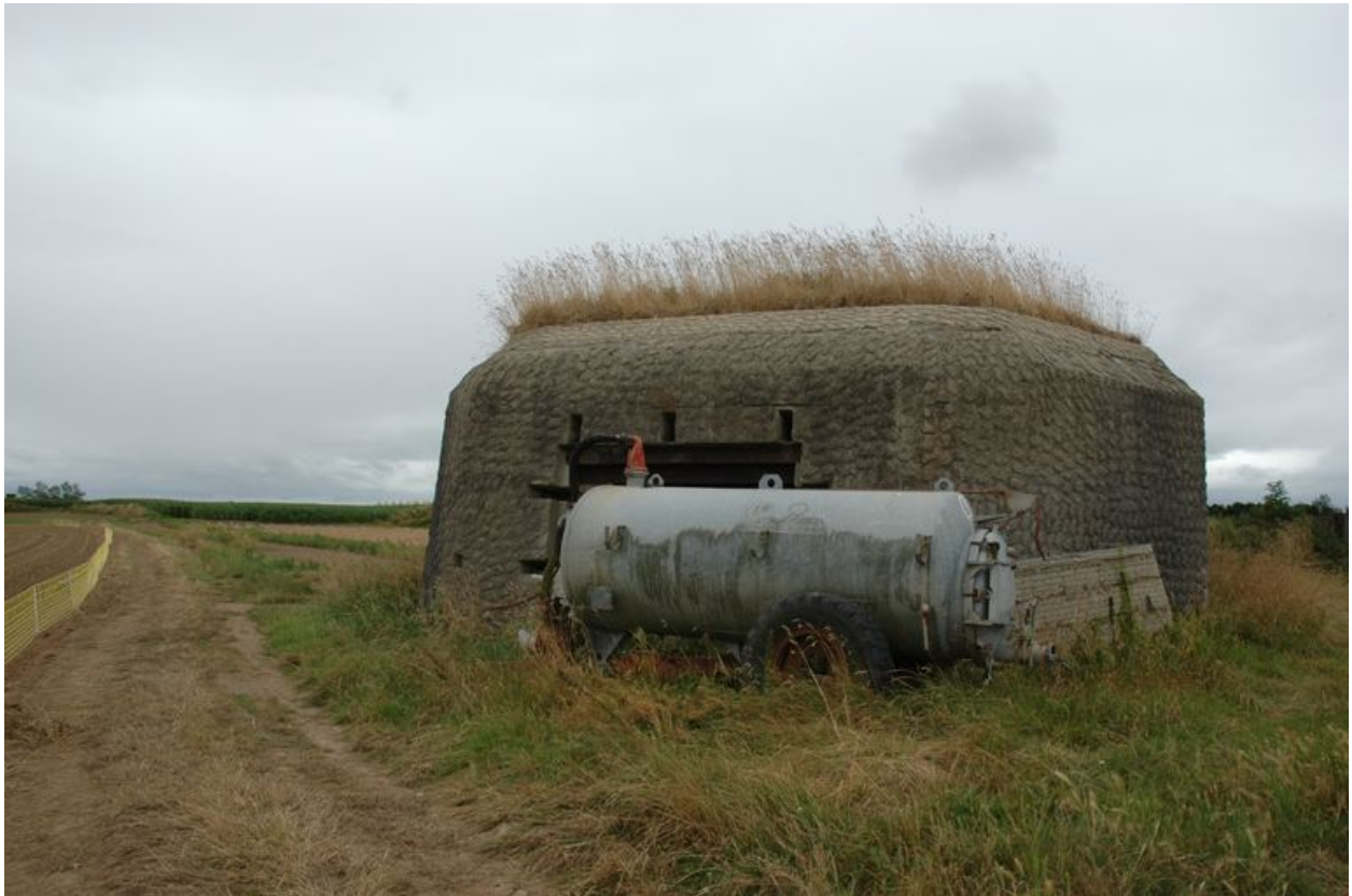
Vue du bunker-casemate nord côté embrasure (état en 2008)
