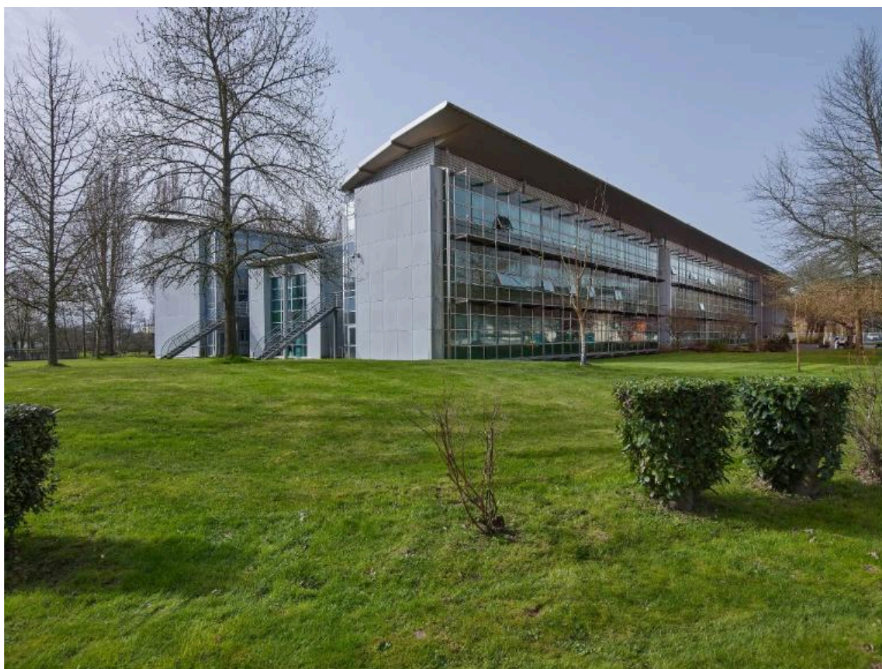
Vue d'ensemble du bâtiment principal, prise du nord-est. Joël Y. Gautier, architecte, 1992.
