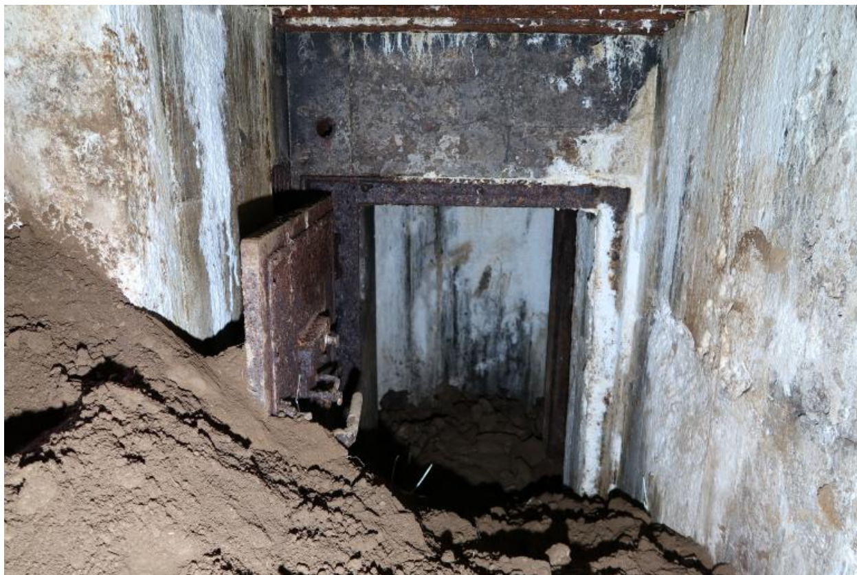
Vue du couloir d'entrée en partie remblayé : porte blindée du sas (à gauche)
