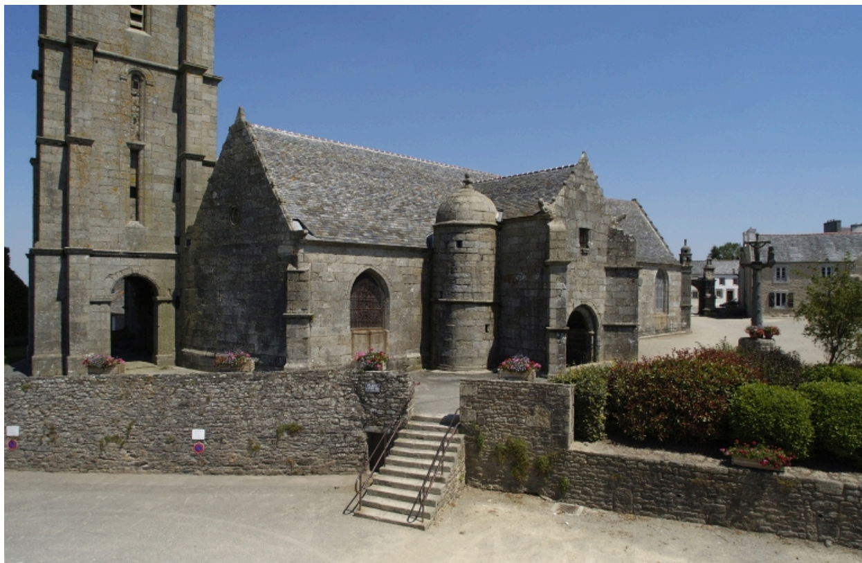
Elévation sud, partie ouest, vue partielle
