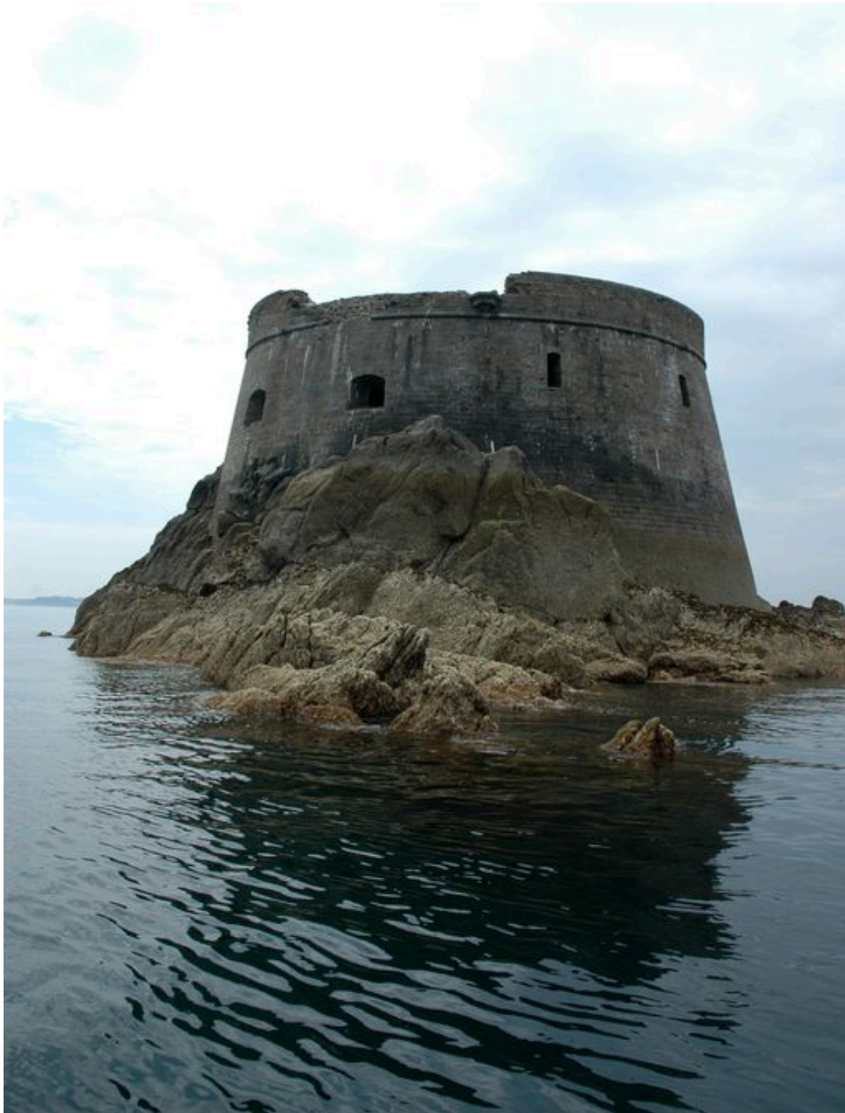
Vue générale du fort de la Conchée
