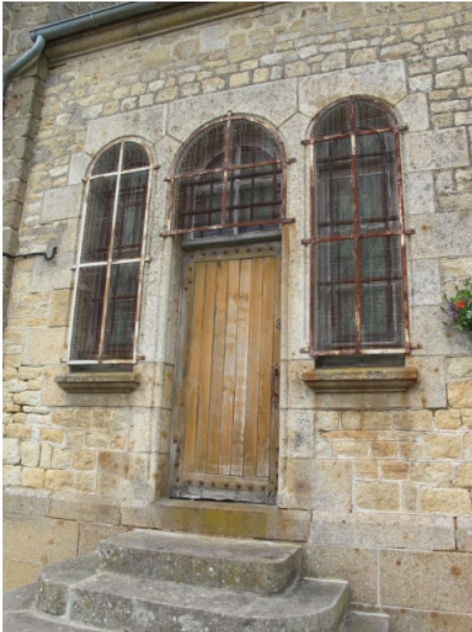
Façade sud, partie ouest
