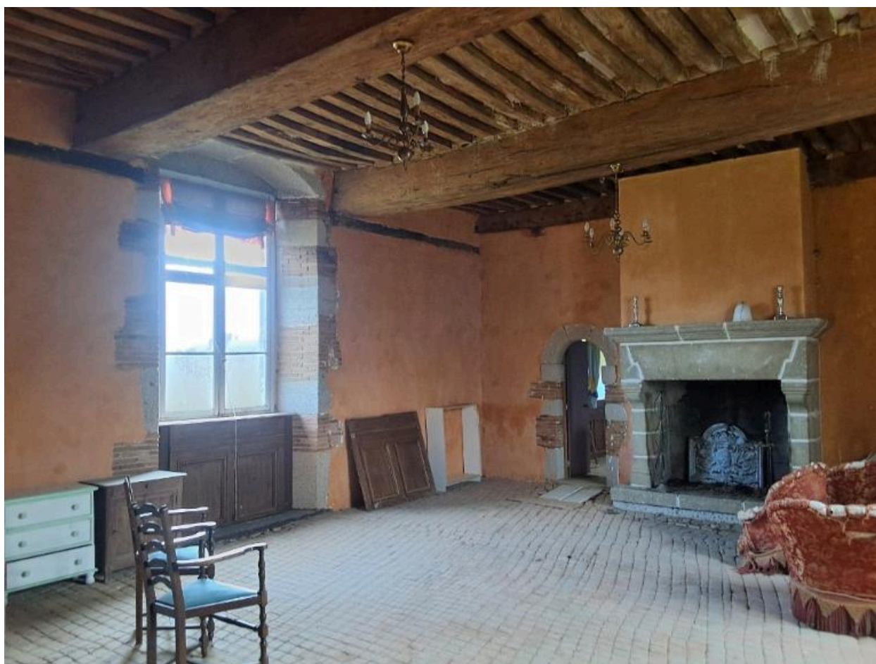
Premier étage, partie est, première salle à gauche de l'escalier
