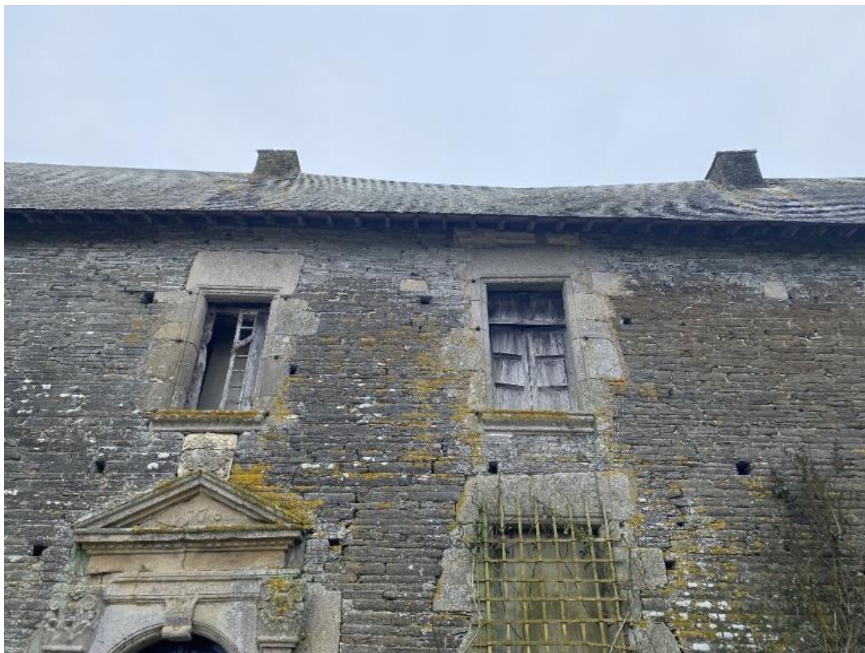
Élévation ouest, détail
