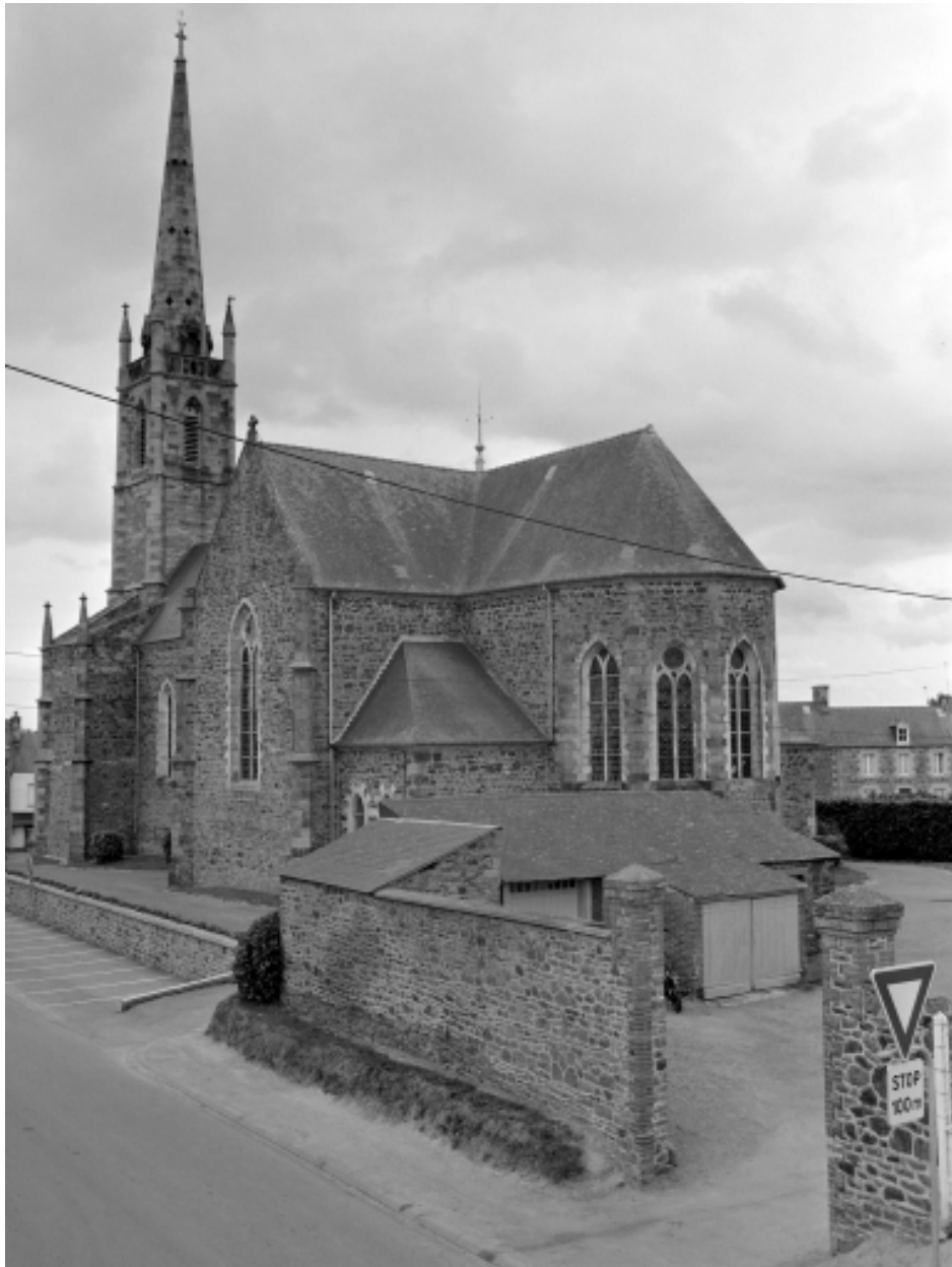
Elévation Sud-Ouest : vue générale
