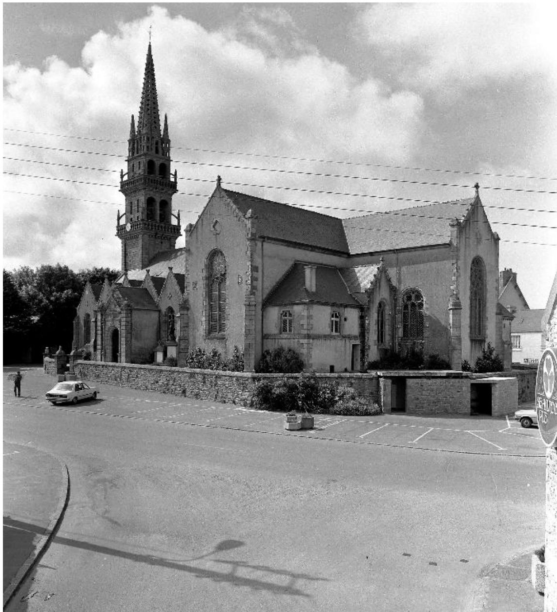
Église : vue générale prise du sud-est (état en 1986)
