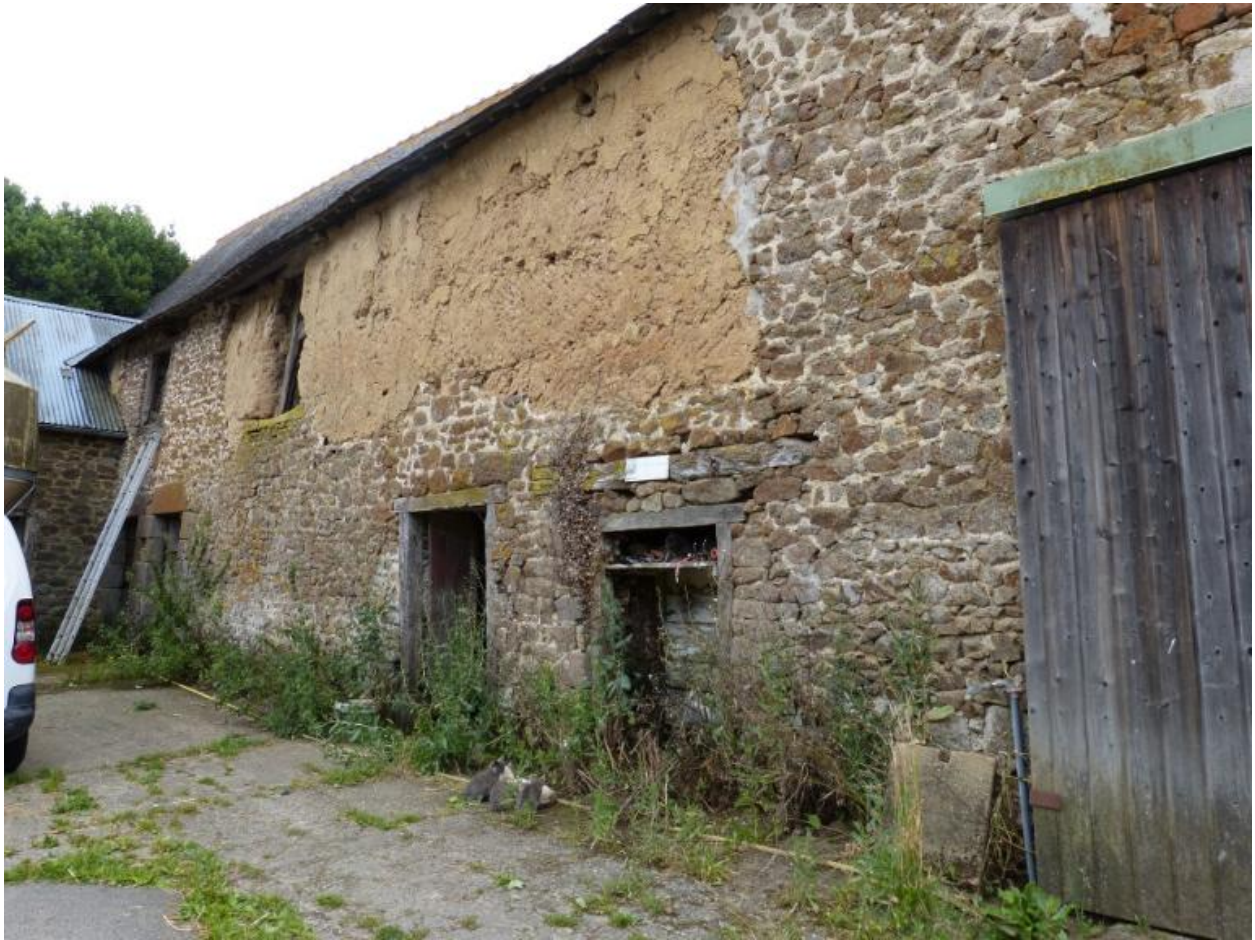
Vue générale nord est, Ferme, La Ville Allée (Hédé-Bazouges)
