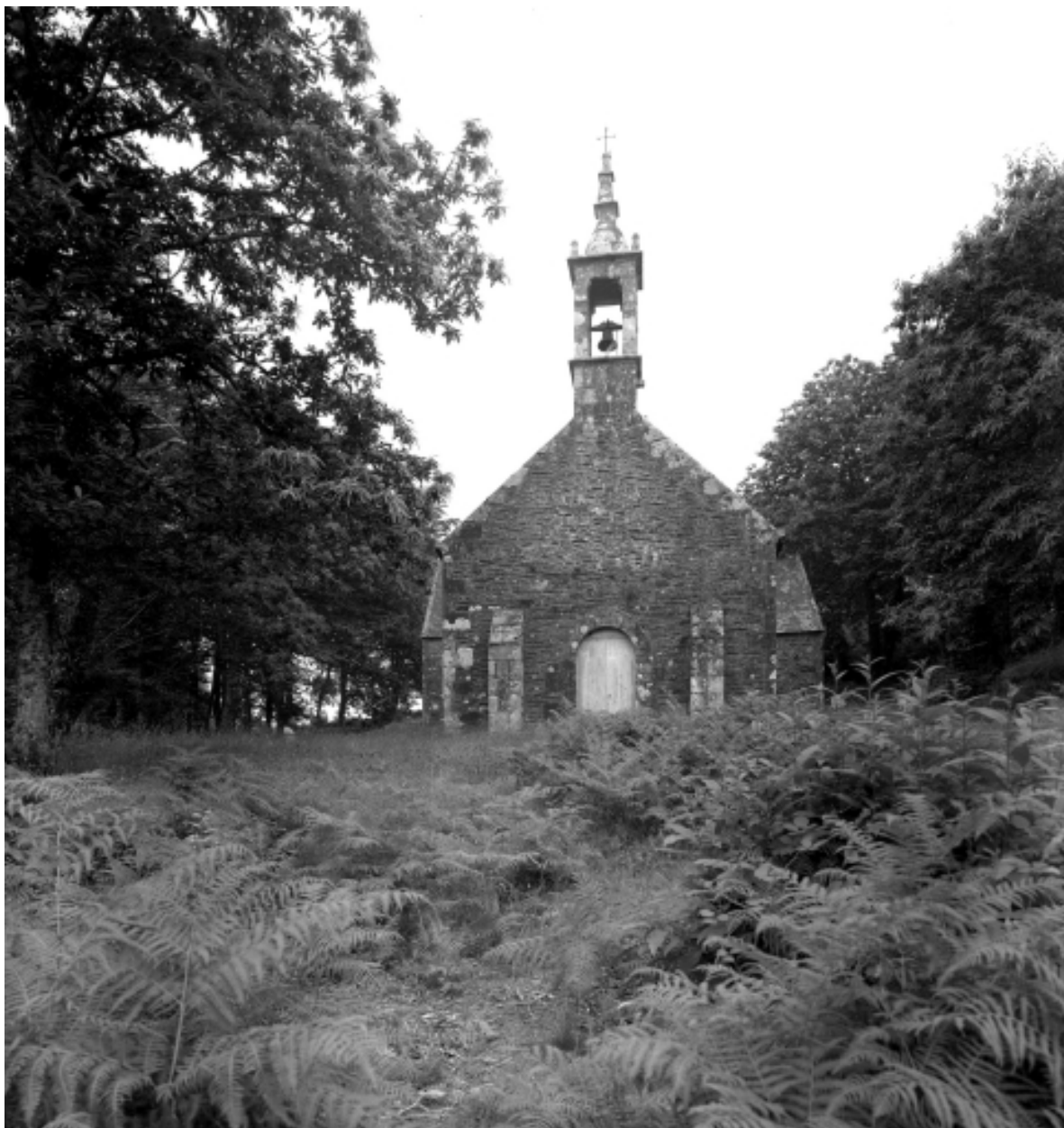
Saint-Thois, chapelle Saint-Laurent : vue générale ouest, état en 1966
