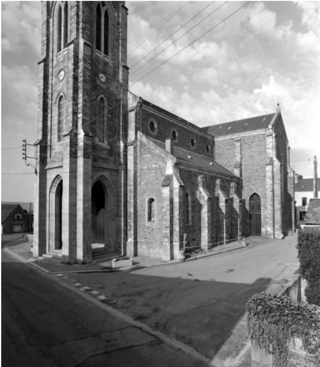
Le clocher-porche : vue générale nord-est
