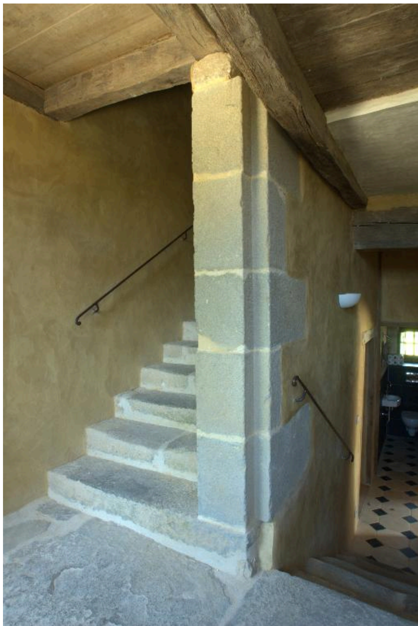
Vue de l'escalier du logis principal
