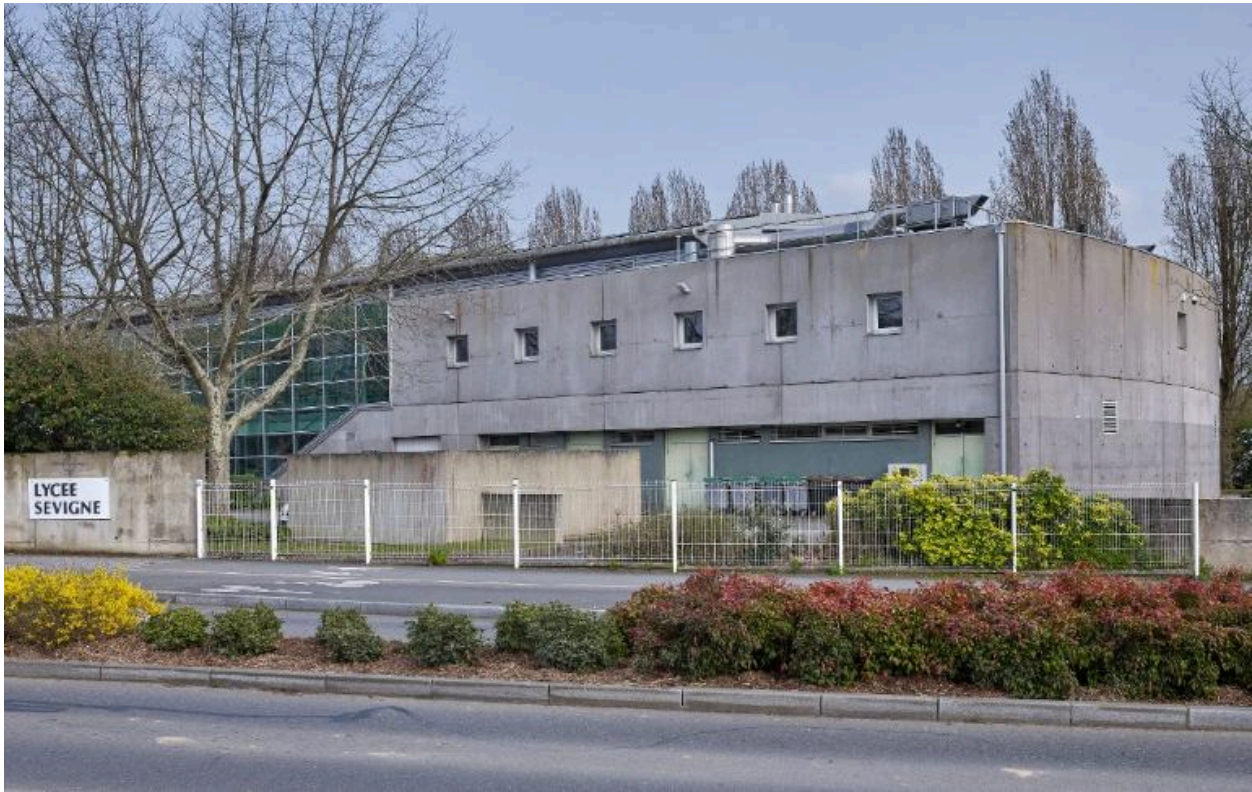
Partie sud de la restauration scolaire (cuisines et locaux techniques). Vue prise du sud-ouest. Joël Y. Gautier, architecte, 1992.
