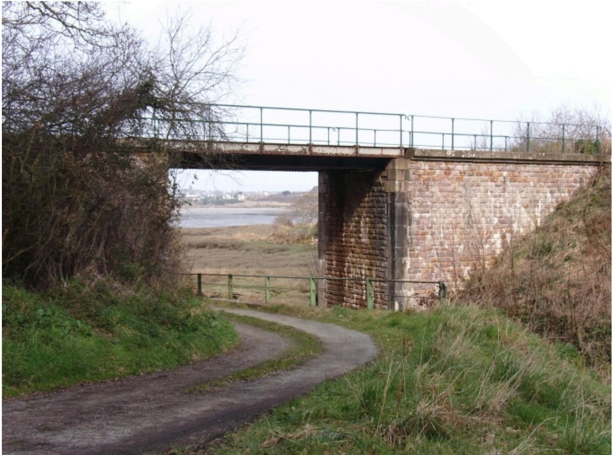
Vue générale sud-ouest du passage inférieur de Traou-Du : ouvrage à tablier métallique construit en pierre de taille de granite à ton clair et moellons de grès rose équarris polygonaux
